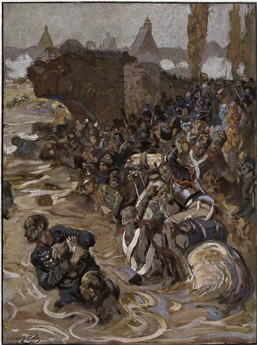
Die Sprengung der Elsterbrücke
